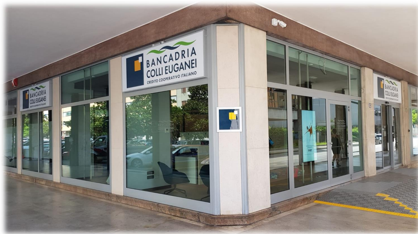
Esterni della nuova Filiale di Padova, via Gaspare Gozzi, 12
